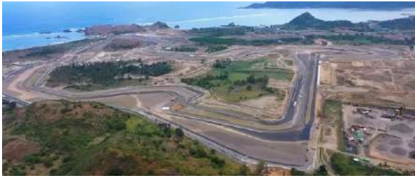
Gbr. 1. Pembangunan Sirkuit Mandalika.
