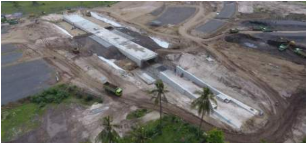
Gbr. 23. Pelaksanaan Pekerjaan Box Tunnel atau Terowongan dibawah Track Sirkuit.
