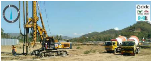
Gbr. 22. Pelaksanaan Pekerjaan Perbaikan Tanah Dasar dengan Metode CMC.
