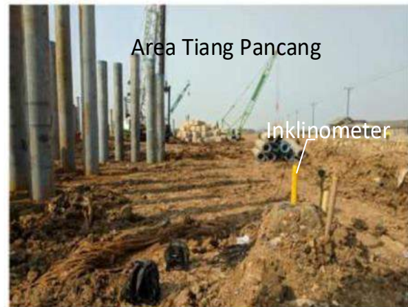
Gbr. 2. Kondisi di lokasi studi, Jarak antara tiang pancang dan Inklinometer.
